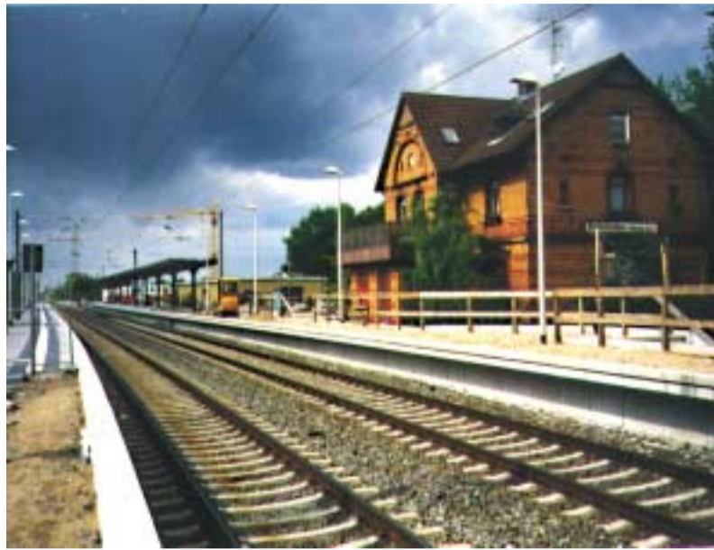
Die neue zweigleisige S-Bahn-Trasse mit altem Bahnhofgebäude von der Südseite aus gesehen. Der neue Bahnsteig im Hintergrund ist überdacht.
