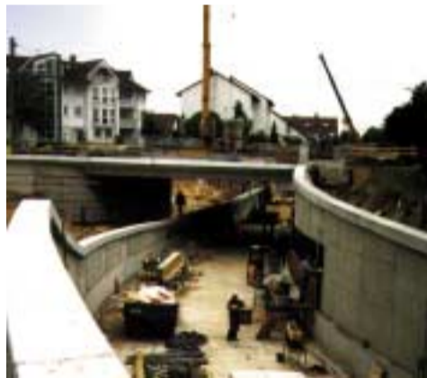
Ebenfalls Mitte 2003 noch im Bau die große Unterführung Mainzer Straße. Im Hintergrund auf der Westseite die Wohnhäuser des ehem. Kögel-Geländes.
