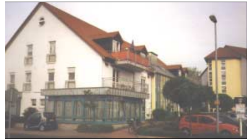
■ Das sechs Jahre alte, Alten- und Pflegeheim an der Feldstraße, das „Gretel-Egner-Haus“, benannt nach der schon legendären einstigen Gemeindegewesenerin.
