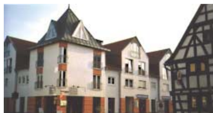
Heute links ein großes Geschäftshaus, rechts das restaurierte Fachwerkhaus (Apotheke, früher Resch) auf beiden Fotos zu erkennen.
